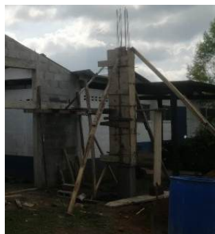
Construcción de bodega
