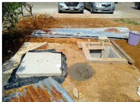
Construcción de cisterna
