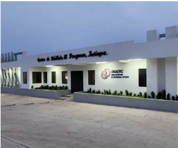
Nueva instalación Sede Regional El Progreso, Jutiapa
